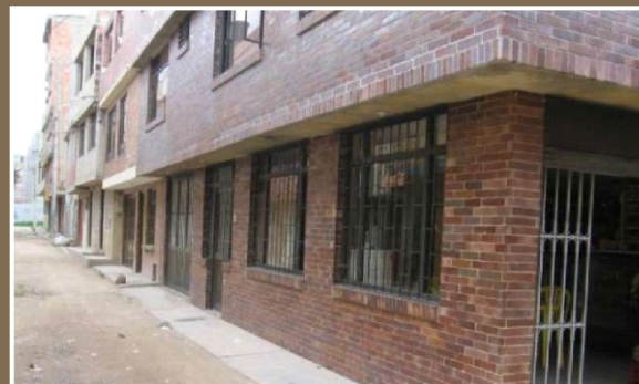
Tipología B3: Construcciones de calidad regular o buena, realizadas con materiales tradicionales (concreto, mampostería, hierro, etc.)
