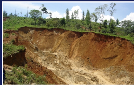
Foto 10. Deslizamiento rotacional en suelo residual
