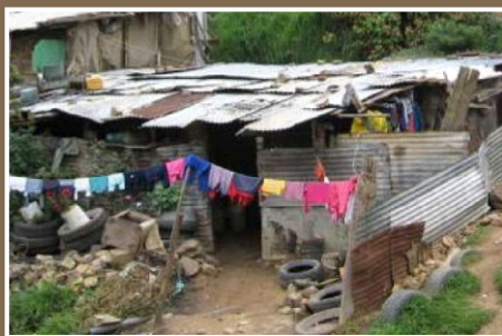
Tipología B1: Construcciones de muy mala calidad, sin fundación ni ligazón estructural.
